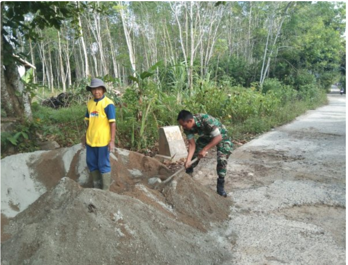
Babinsa Bantu Gotong Royong Pengecoran Jalan
