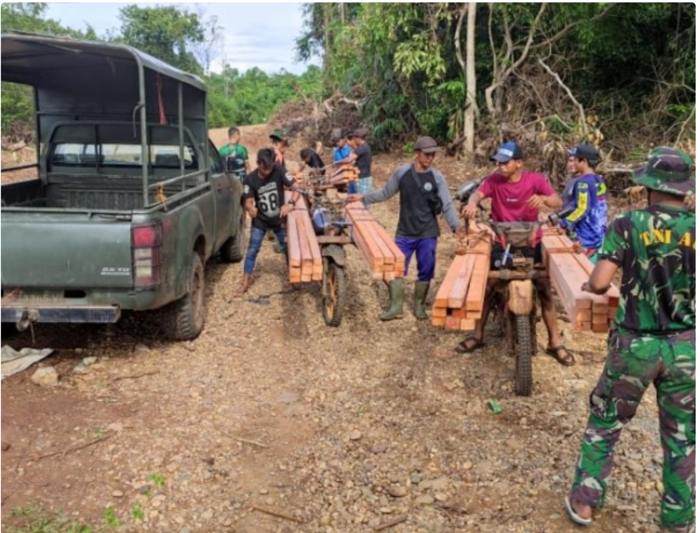
Warga Bantu Bawa Balok Kayu Untuk Jembatan
