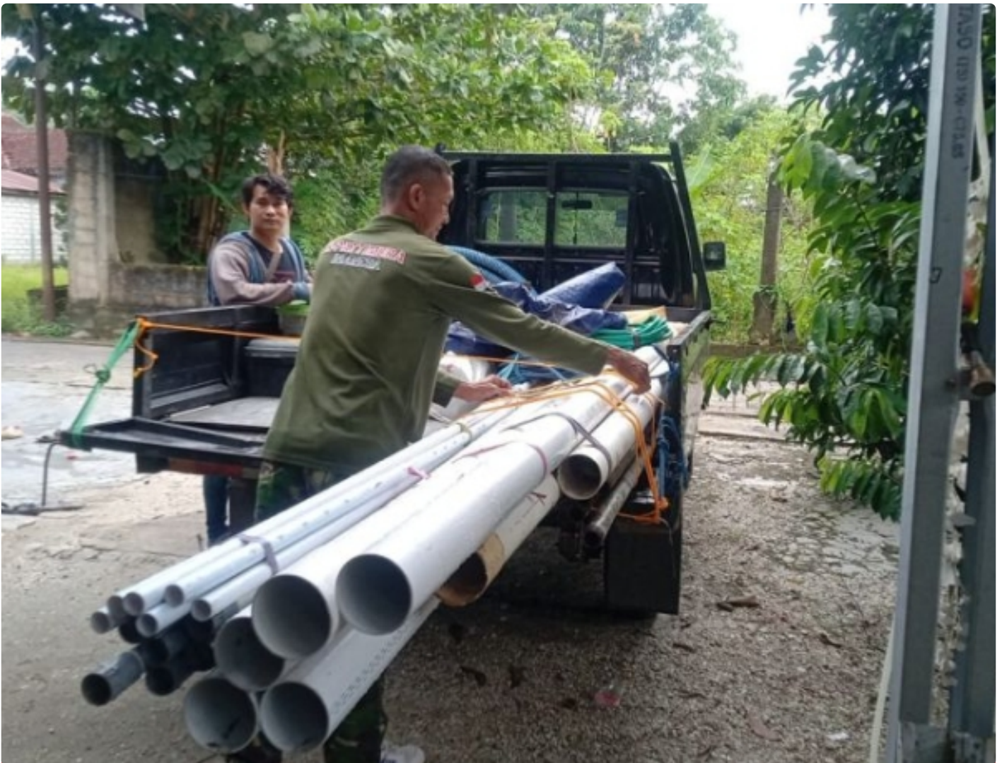
Satgas TMMD ke-113 Kodim 1006/Banjar Angkut Materiil pembuatan Sumur Bor
